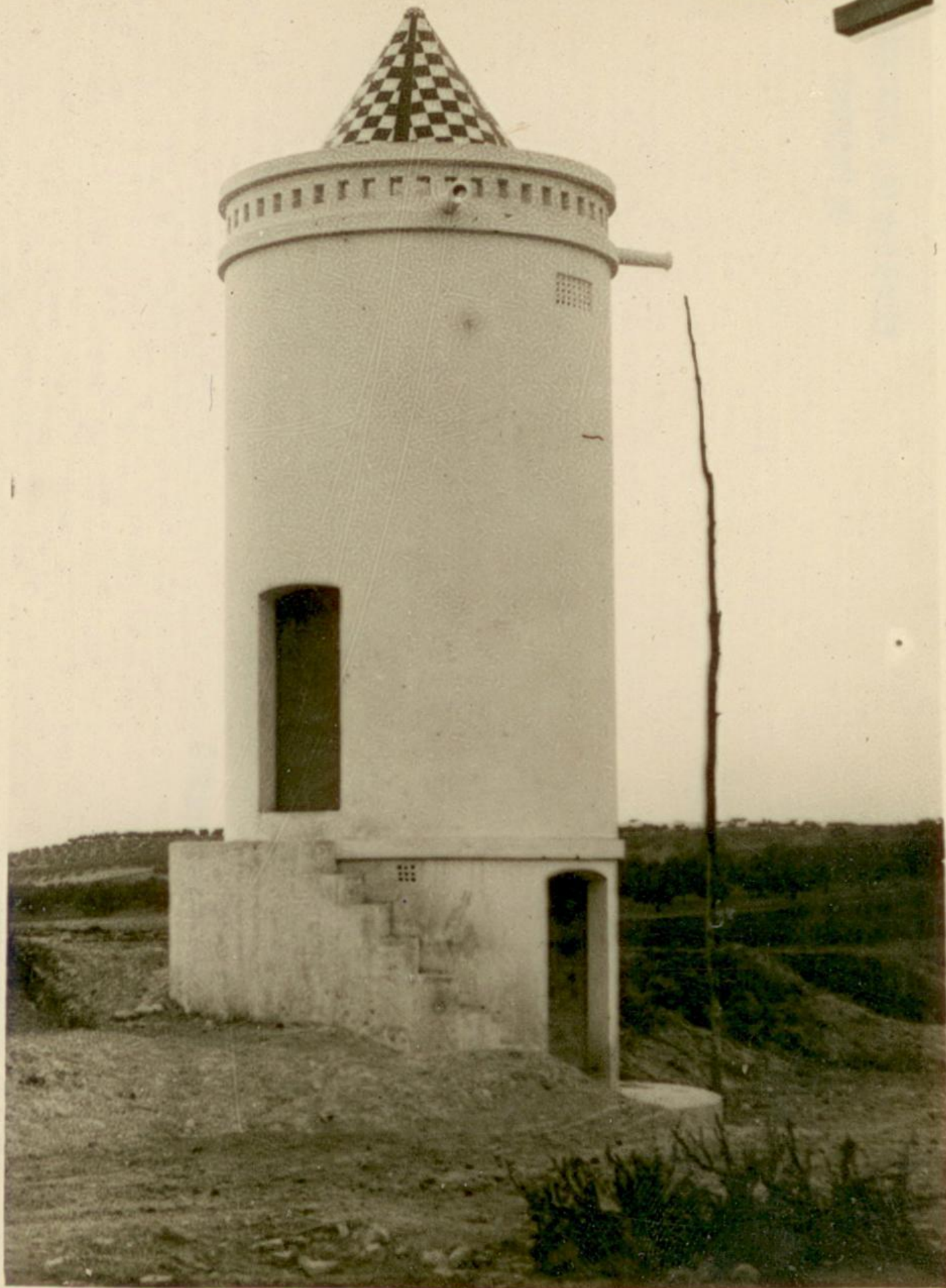
PARADAS 1944. Abastecimiento de aguas Birrete (ARAUCA)
